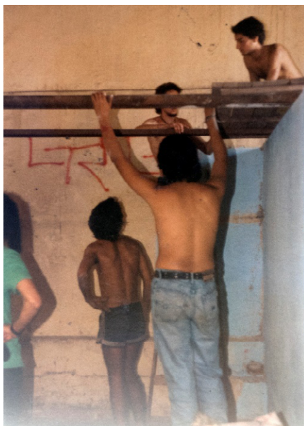
Figura 2. Montaje de entrepisos
