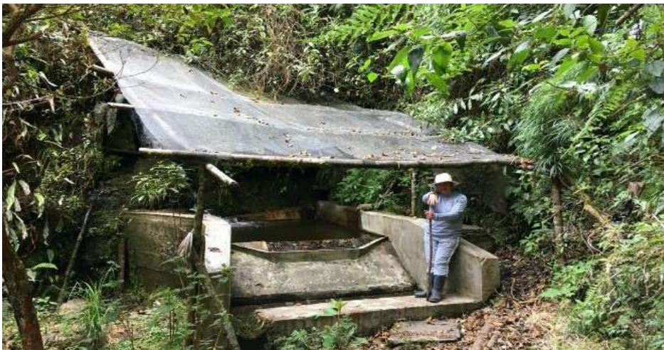
Figura 4. Bocatoma del Tambillo
