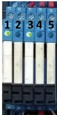
**Figura 53:** Luces indicadoras para cada uno de los movimientos
